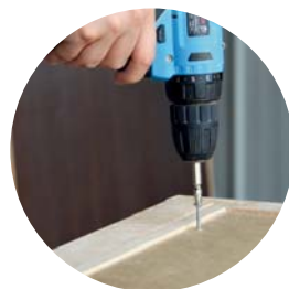
Přípevnění krytu stropu
