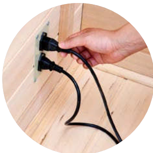
Zapojené káble ohrievačov
