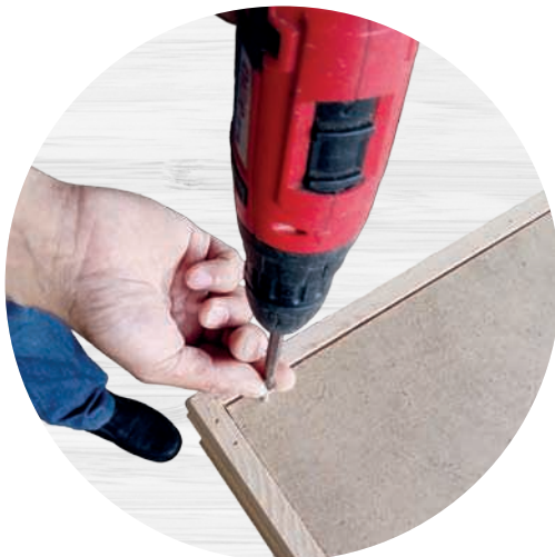
Montáž krytu stropu
