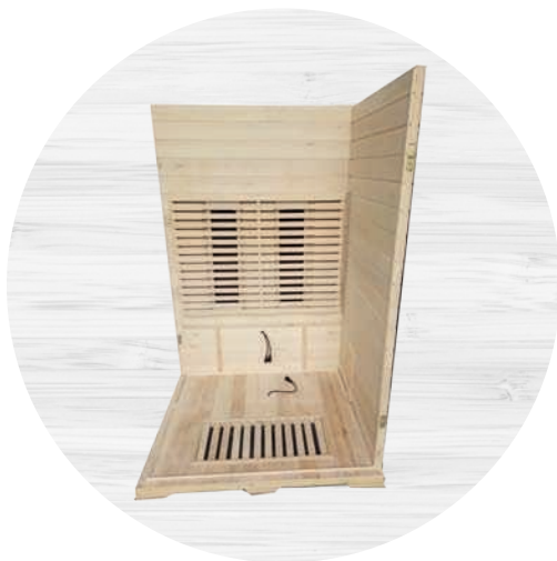
Umístěná pravá stěna
