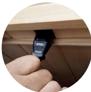
Ukázka protažení kabelů
