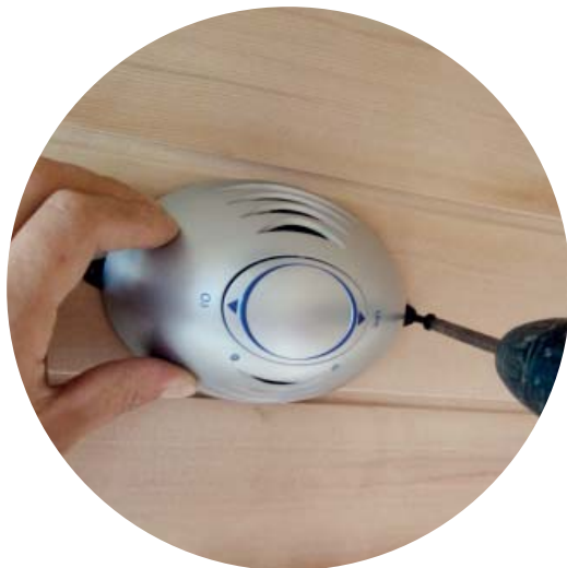
Instalace ionizátoru
