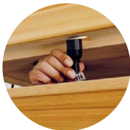
Protážení napájecího kabelu topidla skrz strop
