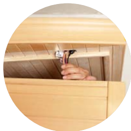
Protážení svazku kabelů ovládacího panelu od čelní stěny do stropu
