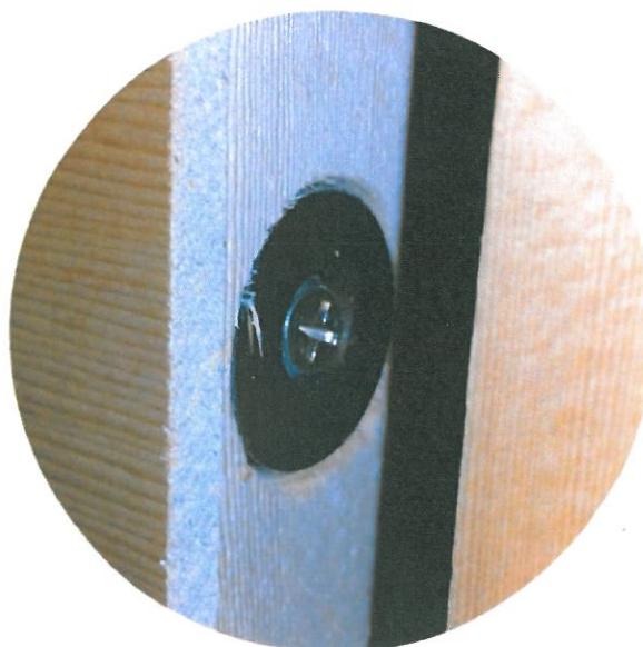
System spojní stěn
