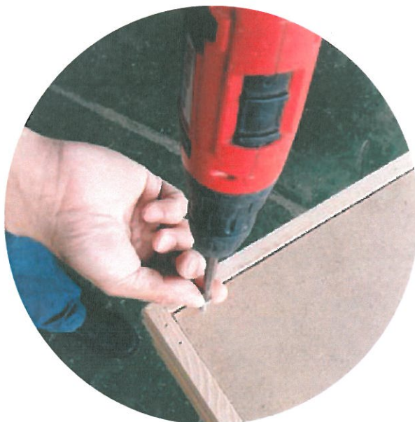
Instalace krytu stropu
