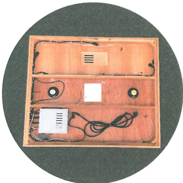
Vrchní část stropu
