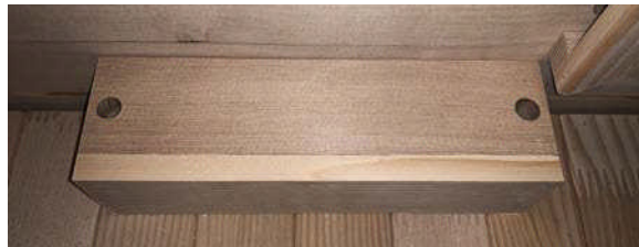
Zakrytý spoj káblov
