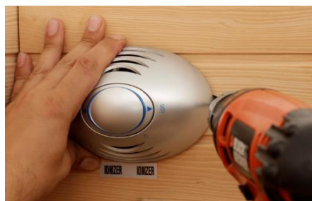
Foto č. 20 – přišroubování ionizátoru
