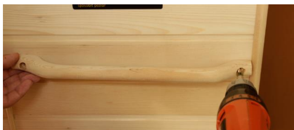
Foto č. 21 – přišroubování držáku na ručníky
