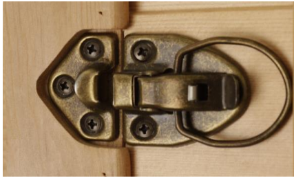
Foto č. 4 – nezajištěná spona
